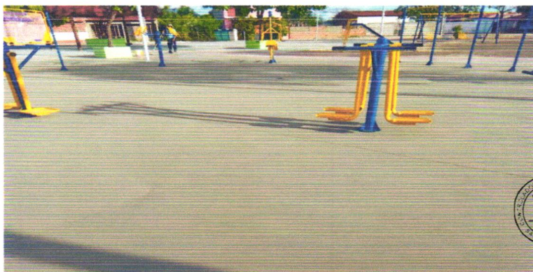
Foto 10 - PINTURA DE PISO COM TINTA ACRÍLICA, APLICAÇÃO MANUAL, 2 DEMÃOS, INCLUSO FUNDO PREPARADOR. AF_05/2021
