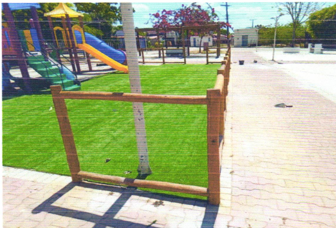
Foto 09 - FORNECIMENTO E MONTAGEM DE CERCA DE PROTEÇÃO EM EUCALIPTO GLOEZIANA TRATADO A BASE DE CCA EM AUTOCLAVE, COM APLICAÇÃO DE STAIN NA COR NATURAL COM DUPLO FILTRO SOLAR, DIÂMETRO DO EUCALIPTO DE 6 A 8 CM, COM ANTI-RACHA NA EXTREMIDADE. FECHAMENTO COM TELA DE ALAMBRADO FIO Nº 12 REVESTIDO DE PVC, MALHA 2.1/2 X 2.1/2", FIXADO COM FIO Nº 14 REVESTIDO EM PVC, MÓDULO MEDINDO 1,50 X 1,00M, PARAFUSOS GALVANIZADOS COM TRAVAMENTO CLICKFIX, CONFORME PROJETO
