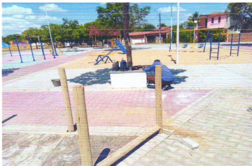
Foto 08 - FORNECIMENTO E MONTAGEM DE CERCA DE PROTEÇÃO EM EUCALIPTO CLOEZIANA TRATADO A BASE DE CCA EM AUTOCLAVE, COM APLICAÇÃO DE STAIN NA COR NATURAL COM DUPLO FILTRO SOLAR, DIAMETRO DO EUCALIPTO DE 6 A 8 CM, COM ANTI-RACHA NA EXTREMIDADE. FECHAMENTO COM TELA DE ALAMBRADO FIO Nº 12 REVESTIDO DE PVC, MALHA 2.1/2 X 2.1/2", FIXADO COM FIO Nº 14 REVESTIDO EM PVC, MÓDULO MEDINDO 1,50 X 1,00M, PARAFUSOS GALVANIZADOS COM TRAVAMENTO CLICKFIX, CONFORME PROJETO
