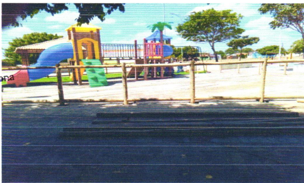
Foto 14 - FORNECIMENTO E MONTAGEM DE CERCA DE PROTEÇÃO EM EUCALIPTO CLOEZIANA TRATADO A BASE DE CCA EM AUTOCLAVE, COM APLICAÇÃO DE STAIN NA COR NATURAL COM DUPLO FILTRO SOLAR, DIÂMETRO DO EUCALIPTO DE 6 A 8 CM, COM ANTI-RACHA NA EXTREMIDADE. FECHAMENTO COM TELA DE ALAMBRADO FIO Nº 12 REVESTIDO DE PVC, MALHA 2.1/2 X 2.1/2", FIXADO COM FIO Nº 14 REVESTIDO EM PVC, MÓDULO MEDINDO 1,50 X 1,00M, PARAFUSOS GALVANIZADOS COM TRAVAMENTO CLICKFIX, CONFORME PROJETO
