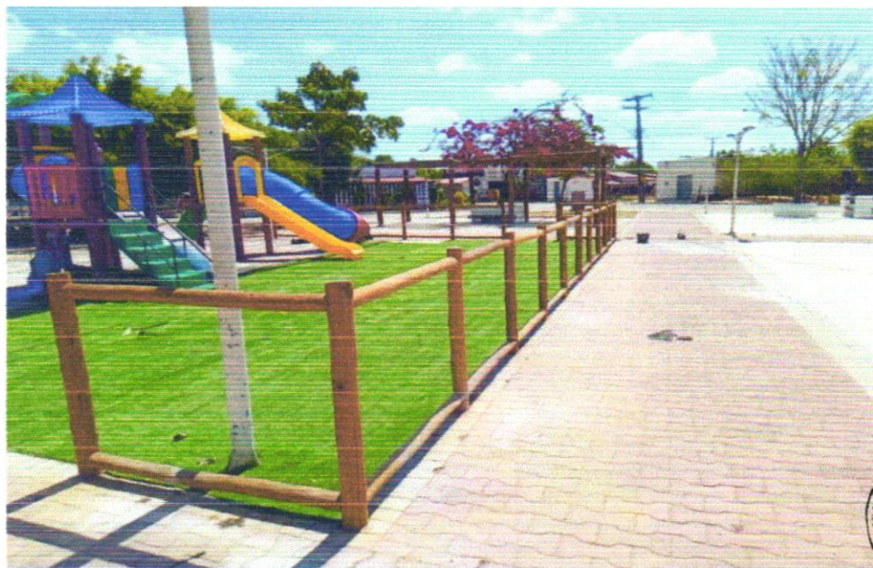
Foto 06 - FORNECIMENTO E MONTAGEM DE CERCA DE PROTEÇÃO EM EUCALIPTO CLOEZIANA TRATADO A BASE DE CCA EM AUTOCLAVE, COM APLICAÇÃO DE STAIN NA COR NATURAL COM DUPLO FILTRO SOLAR, DIÂMETRO DO EUCALIPTO DE 6 A 8 CM, COM ANTI-RACHA NA EXTREMIDADE. FECHAMENTO COM TELA DE ALAMBRADO FIO Nº 12 REVESTIDO DE PVC, MALHA 2.1/2 X 2.1/2", FIXADO COM FIO Nº 14 REVESTIDO EM PVC, MÓDULO MEDINDO 1,50 X 1,00M, PARAFUSOS GALVANIZADOS COM TRAVAMENTO CLICKFIX, CONFORME PROJETO
