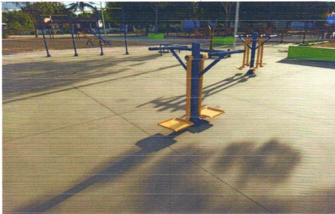
Foto 13 - PINTURA DE PISO COM TINTA ACRÍLICA, APLICAÇÃO MANUAL, 2 DEMÃOS, INCLUSO FUNDO PREPARADOR. AF_05/2021
